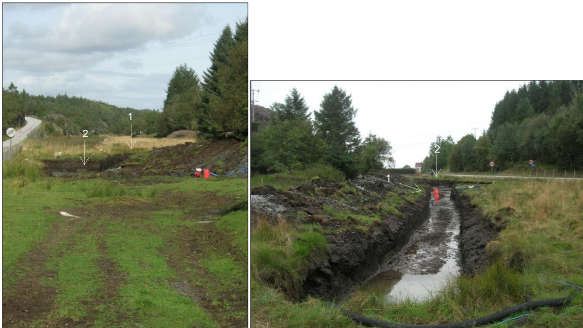
Fig. 1: Utsikt nordover mot basseng (venstre), og sørover mot Vika, lokalitet 3 (høyre), profil 1 og 2. Foto: IKM og AO.
