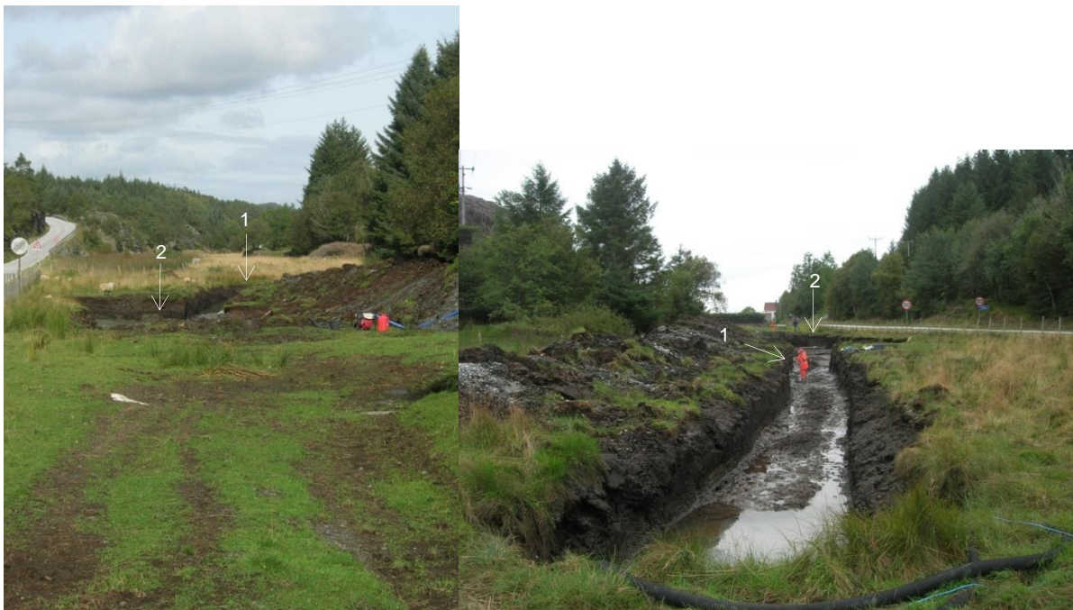
Fig. 2: Utsikt nordover mot basseng (venstre), og sørover mot Vika, lokalitet 3 (høyre), profil 1 og 2. Foto: IKM og AO.
