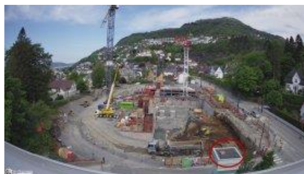
Dette bildet er av byggeplassen, tatt av et kamera som dokumenterer byggeprosessen. I den røde ringen ser man hvor reiret til fiskemåken er plassert etter flytting. (Opphavsrett: Overvåkningskamera)
